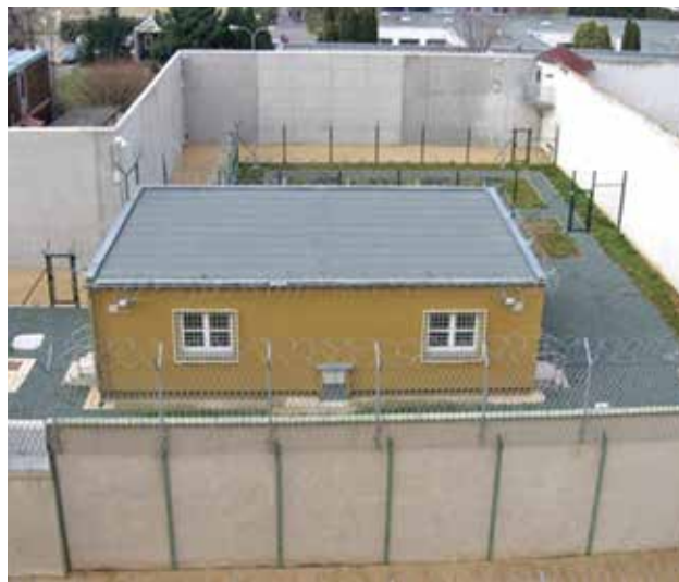
ÚpVZD Brno - střežené pracoviště (prádelna)
