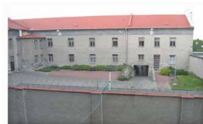
Věznice a ÚVZD Opava - objekt Krnovská – vycházkový dvůr pro chovance
