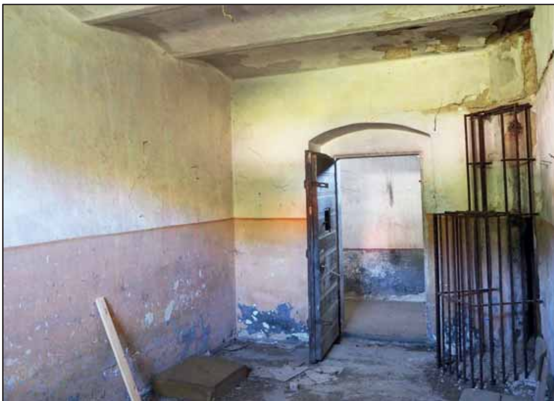
Cela věznice ve Vyšším Brodě s ojediněle dochovanou ochrannou mříží kamen (foto: archiv autora)
