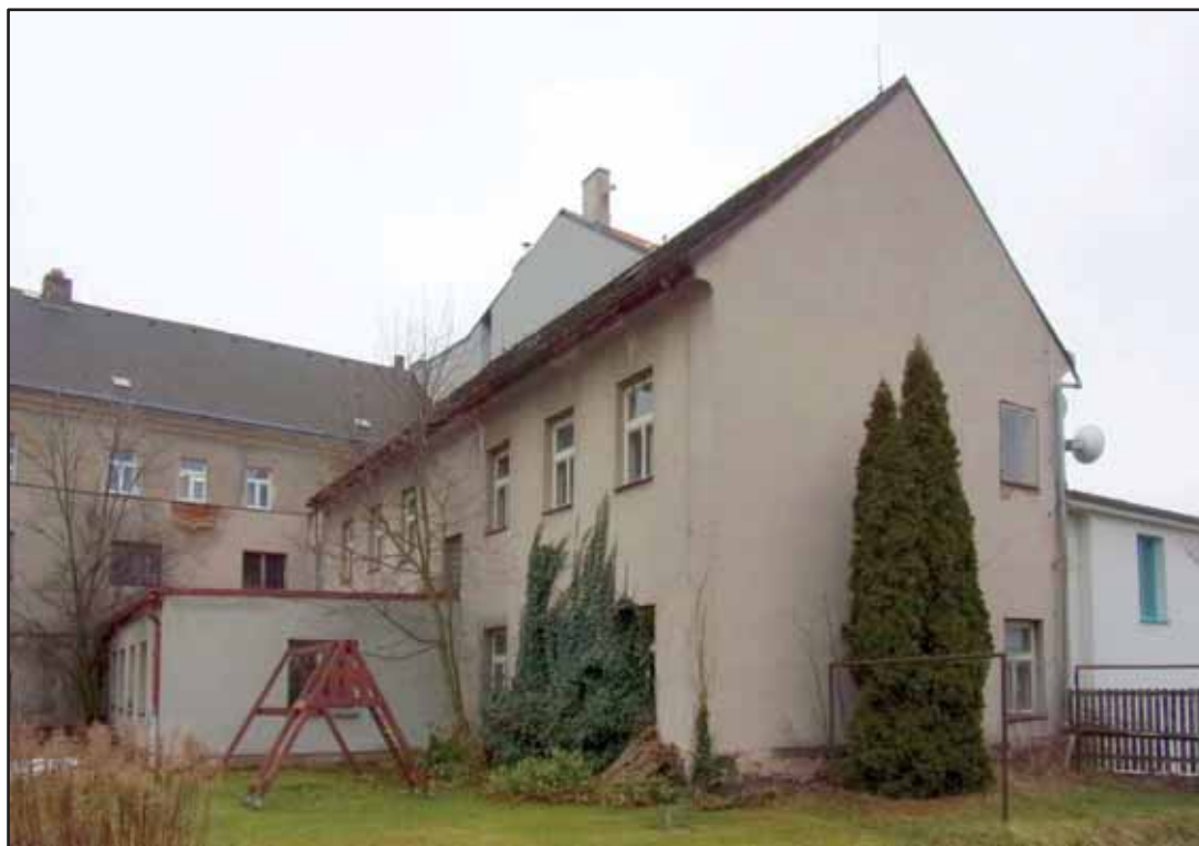
Věznice okresního soudu v Příbrami (foto: archiv autora)
