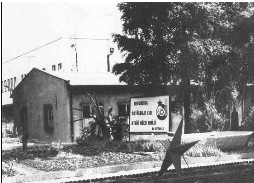
Velkoplošný poutač v areálu NVÚ pro mladistvé v Libkovicích (foto: KDH)
