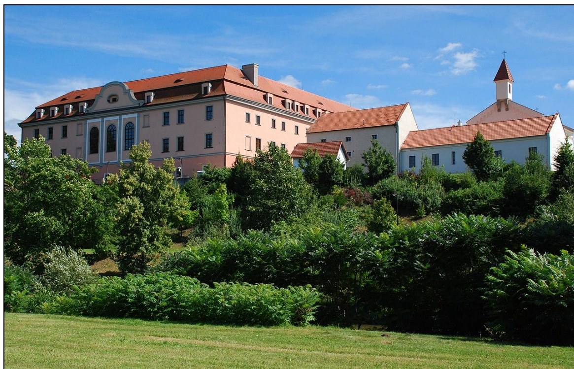
Bývalá trestnice ve Valašském Meziříčí – současný stav (foto: archiv autora)
