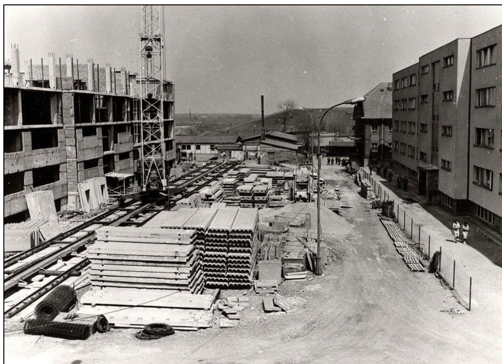
Výstavba v NVÚ Heřmanice (foto: KDH)
