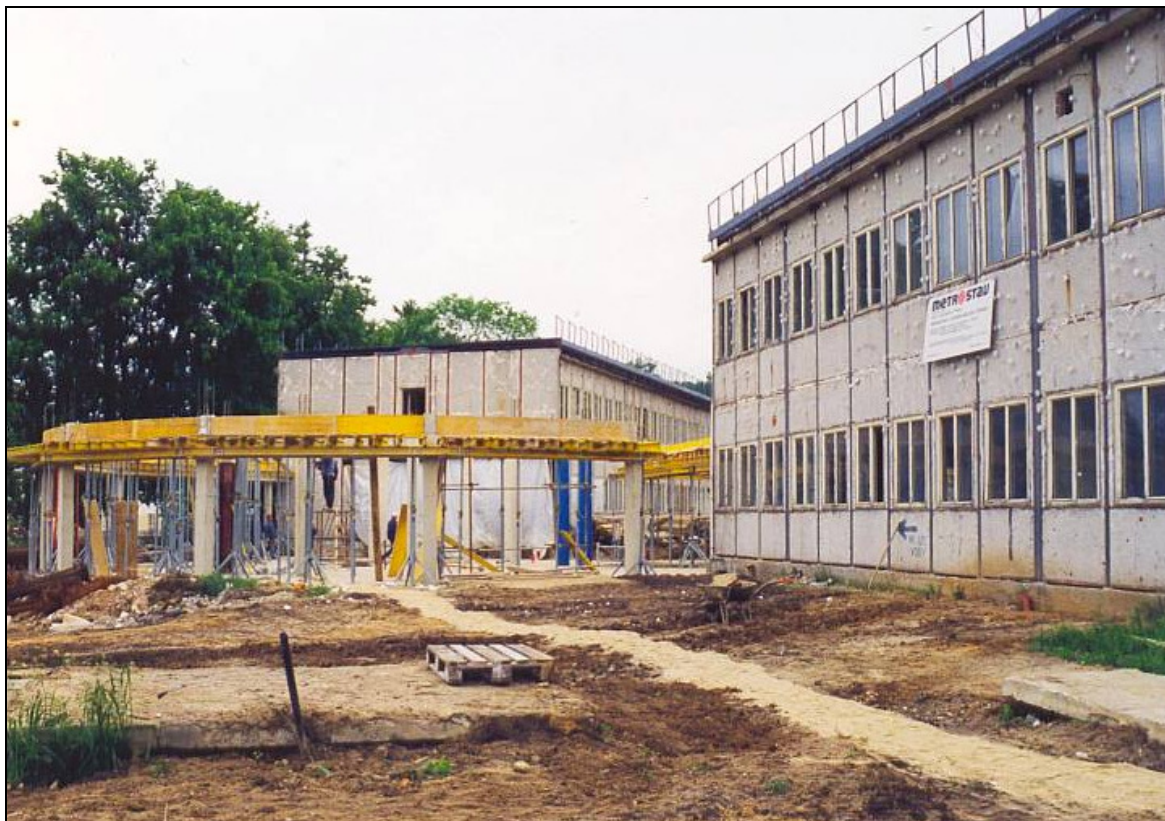
Výstavba nového sídla IV VS ČR (foto: KDH VS ČR).
