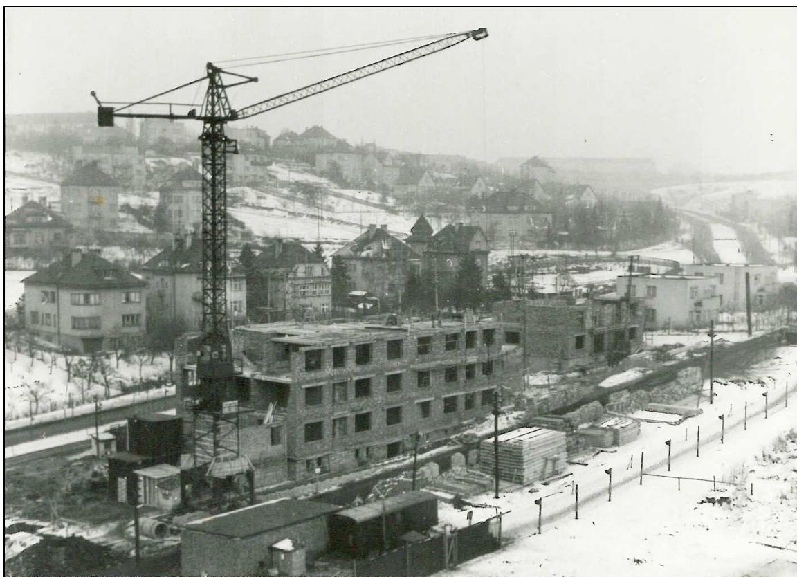
Stavební pracoviště NPT č. 1 v Jeremenkově ulici, Praha 15 (foto: Kabinet dokumentace a historie VS ČR)
