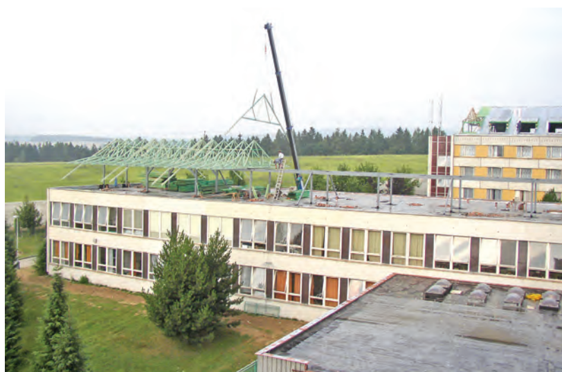
Věznice Světlá v době rekonstrukce, Foto Archiv V Světlé
