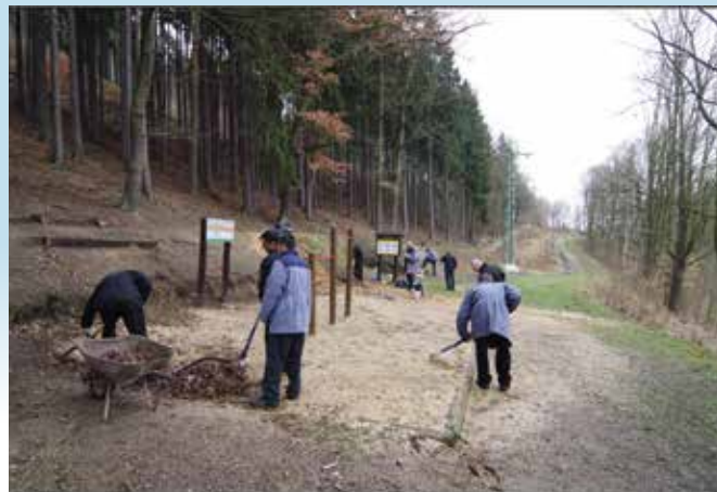
Oprava naučné stezky
