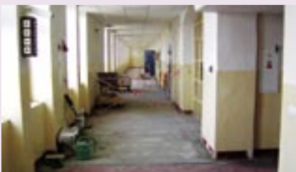
V popředí je ještě stará parketová podlaha, za ní betonový podklad a na konci chodby již nová dlažba
