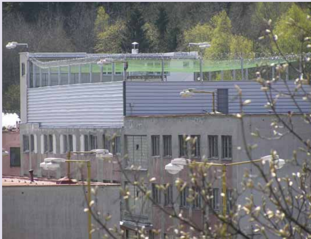
V posledním patře této budovy v Rýnovicích bylo zřízeno OZSTZ. Na střeše budovy je vidět zabezpečený prostor, kam budou chodit odsouzení z tohoto oddělení na vycházky.
